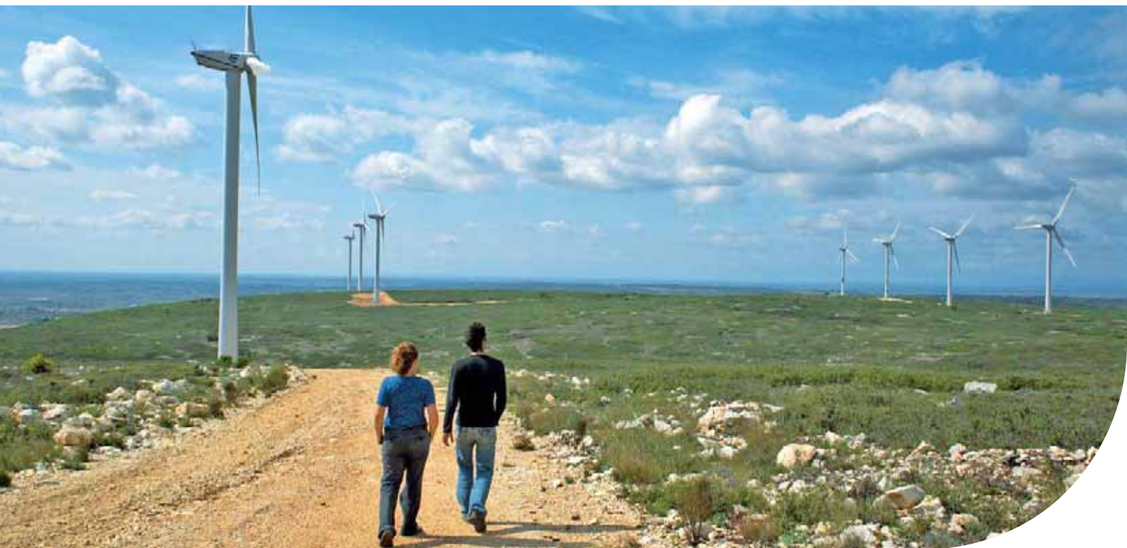
▲ Le parc éolien d'Aumelas, près de Montpellier, est constitué de 11 éoliennes, d'une puissance totale de 22 MW.
