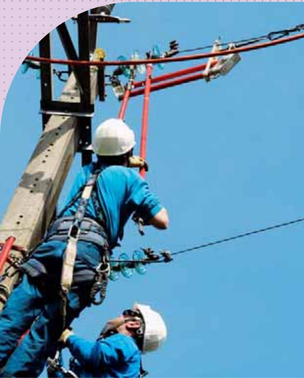
▲ Travaux sous tension effectués par des équipes de EDF Réseau Distribution Sud-Ouest.
