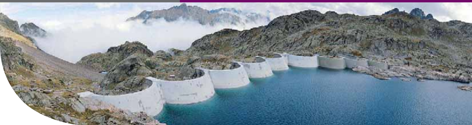
▲ Barrage de Migouélou, dans les Pyrénées.
