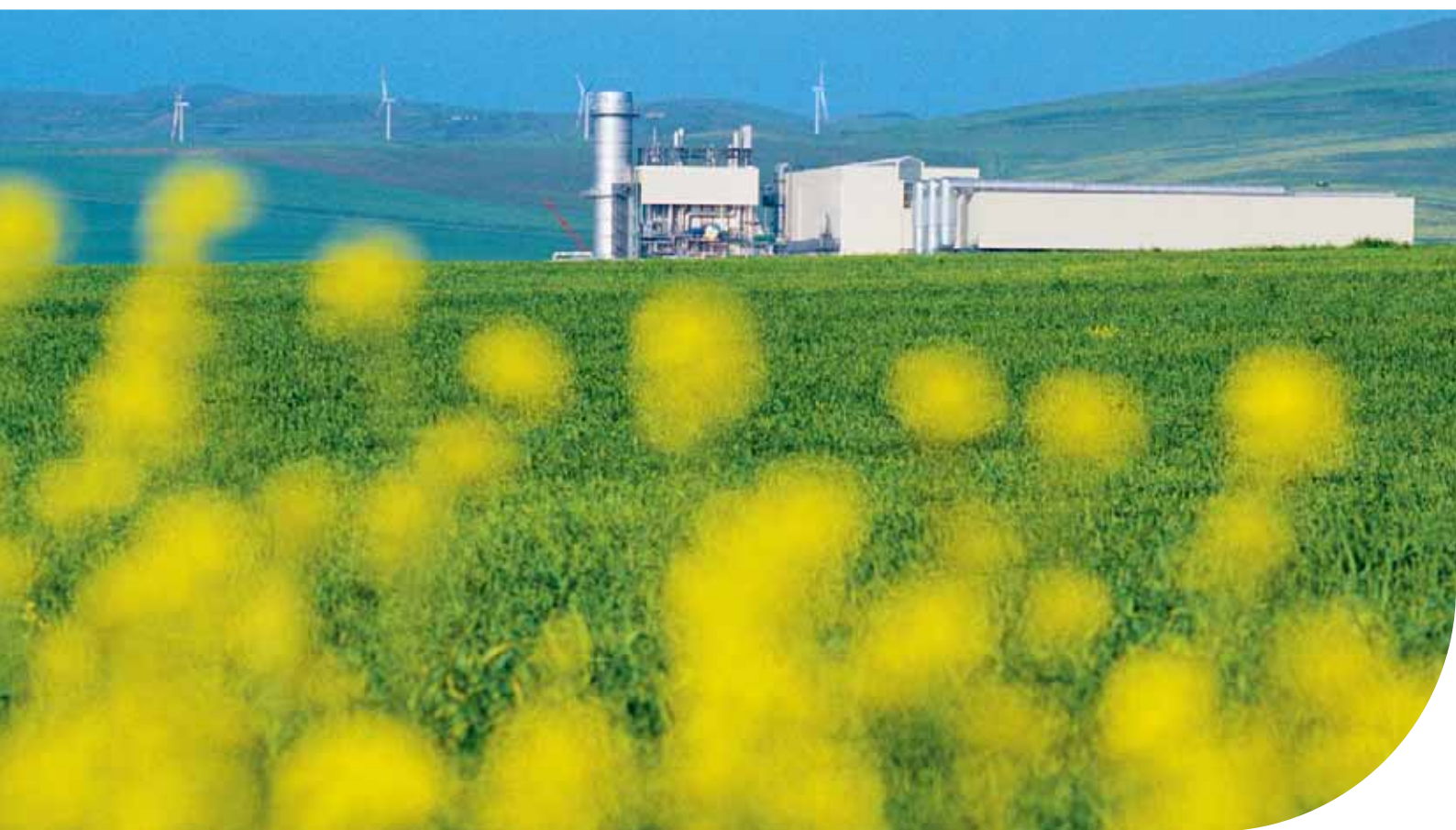
▲ Centrale de cogénération à cycle combiné de Candela.
