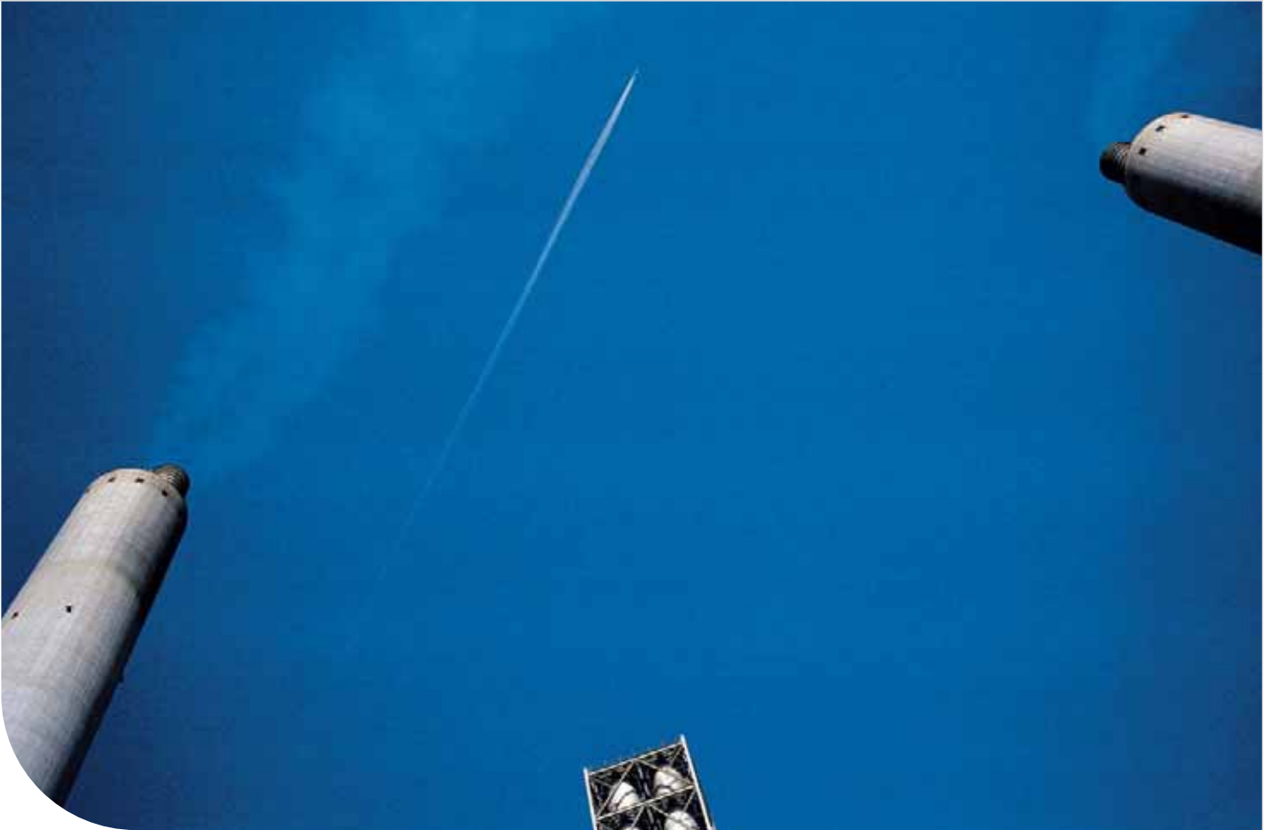
▲ EDF Energy a conduit la désulfuration des centrales thermiques de West Burton (ici) et de Cottam pour supprimer 90 % des émissions de dioxyde de soufre.
