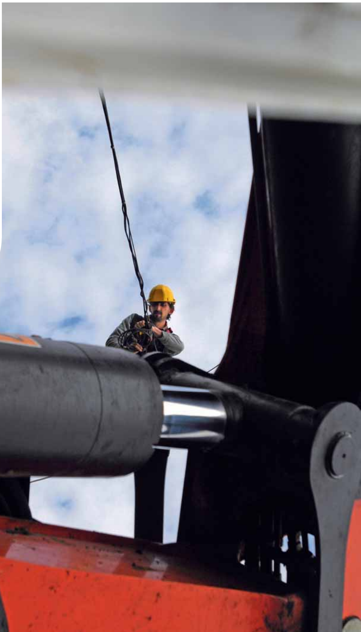
Intervention d'une équipe de réparation des réseaux de Demasz, en Hongrie.
