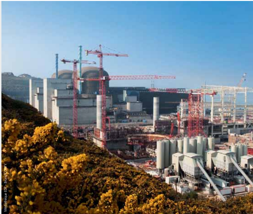
Chantier de construction EPR de Flamanville 3 (février 2009).
