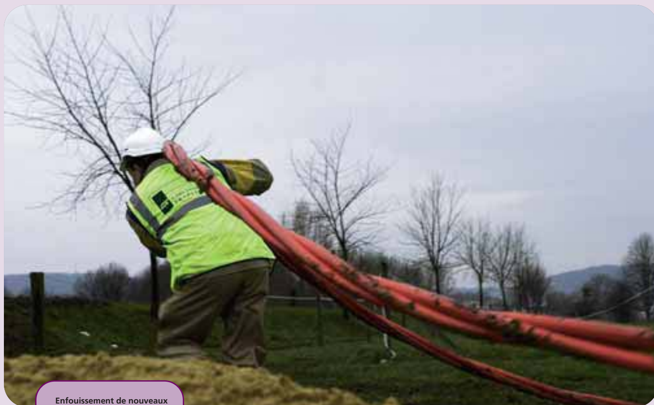
Enfouissement de nouveaux câbles HTA.
